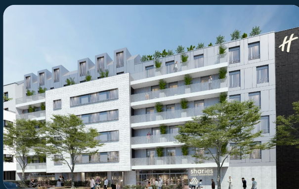
Ensemble immobilier à usage mixte • Nanterre (92) DDD Architectes Associés
